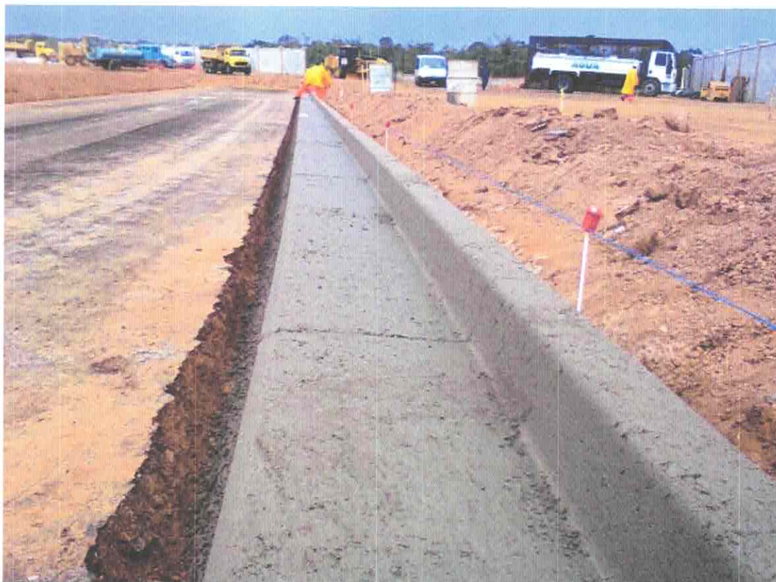
Figura 1 Execução de meio fio conjugado com sarjeta
